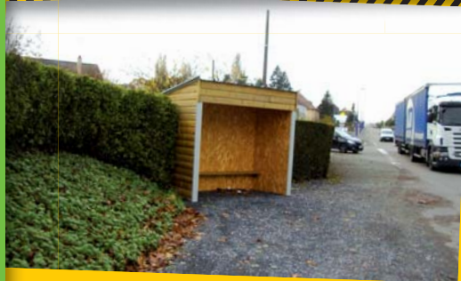
Abri-bus, Avenue de Bretagne
