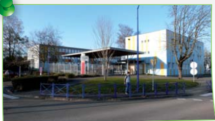
Collège des Avaloirs Tél. : 02 43 03 01 81 - 7 Route de Saint Calais
