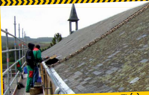
Toiture Eglise Sainte Thérèse
